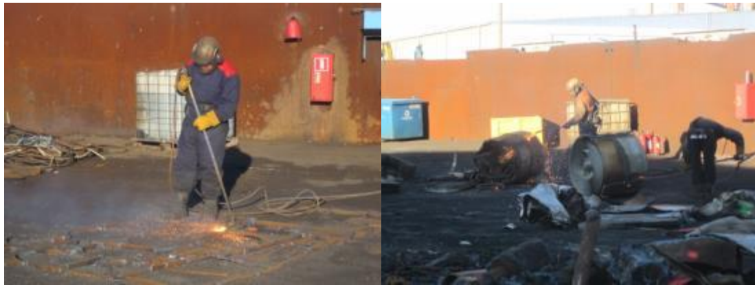
Kuva 2-14. Osa saapuvasta materiaalista polttoleikataan (Kuusakoski Oy 2014).
