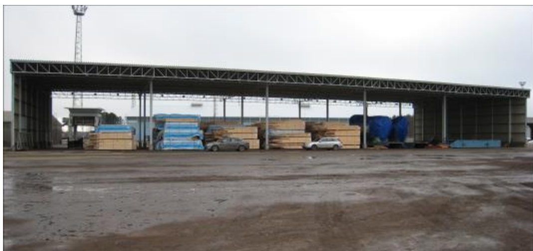
Kuva 5. Nykyinen katos, johon akkuterminaalin toiminta sijoittuu. Kuvaussuunta etelään.
